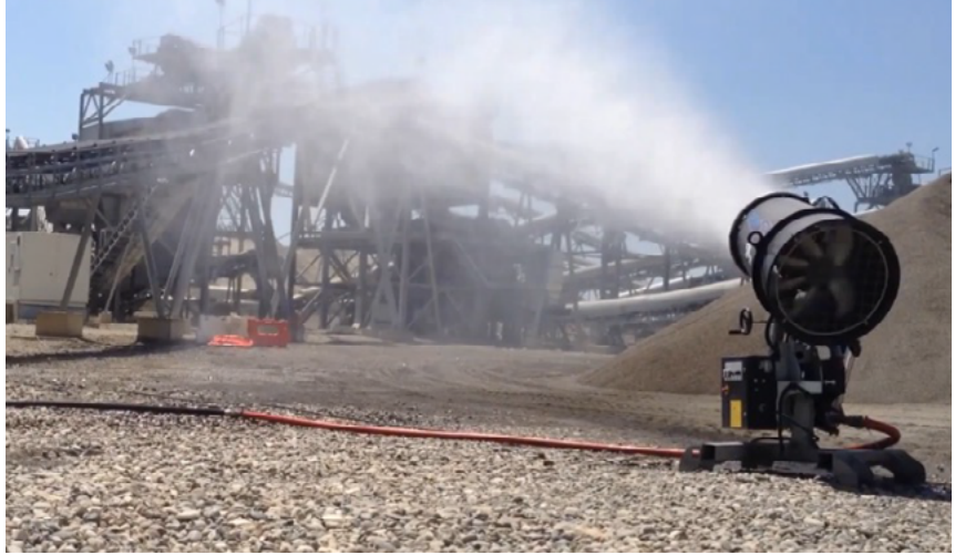
Figure 31. Brumisateurs pour l'abattage de poussières (Source : BRUMSTYL)
